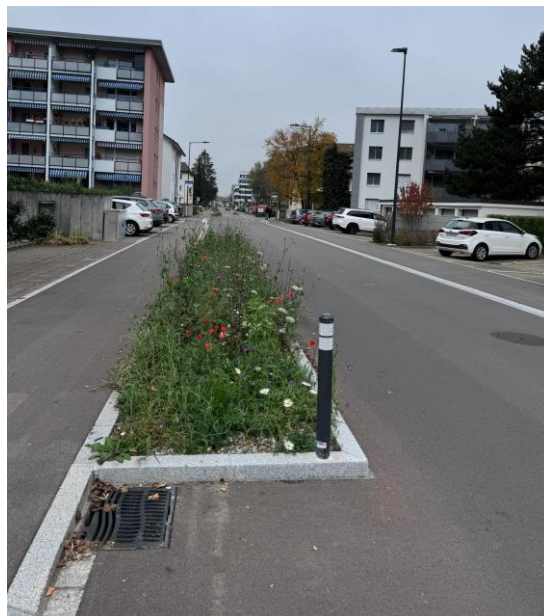
Inverdimento intermedio in ambito stradale
